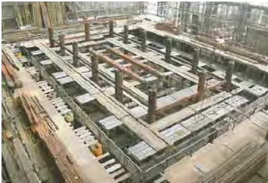
(解体工事の様子)
