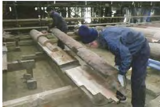
(根継ぎ作業の様子)
