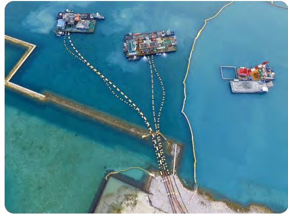
バージアンローダ船による埋立て作業イメージ
