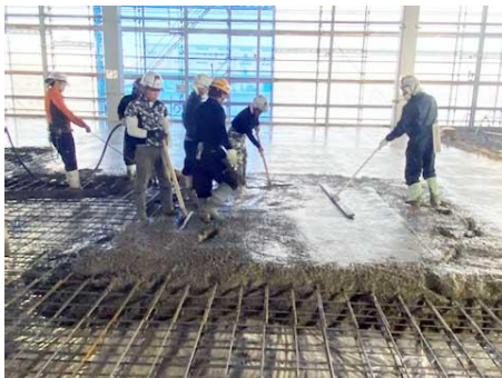
コンクリート作業
