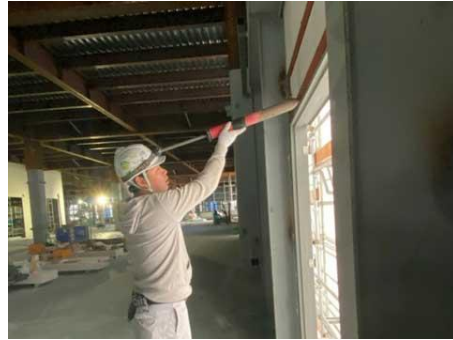
モルタル詰め作業
