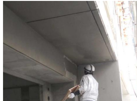
天井薄塗り補修作業
