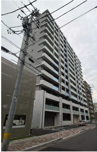
日吉マンション（名古屋市）
