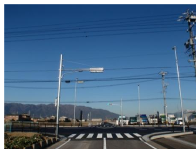
国道 258 号交差点改良
