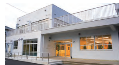
▲保育園を改修した「コネクトベース垂井」
